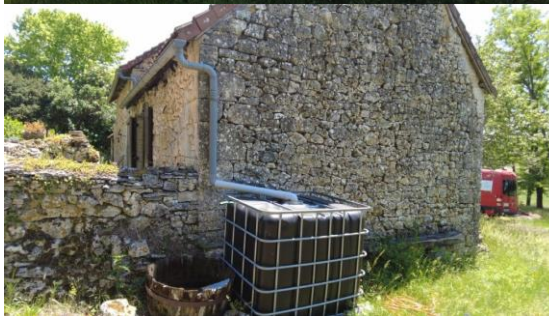
Links: Kleiner Selbstversorgungsgarten auf einem Hof in Südfrankreich, rechts: IBC-Container mit Dachanschluss
